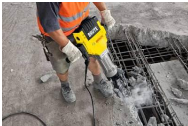
Figura 04 - Demolição controlada de concreto
