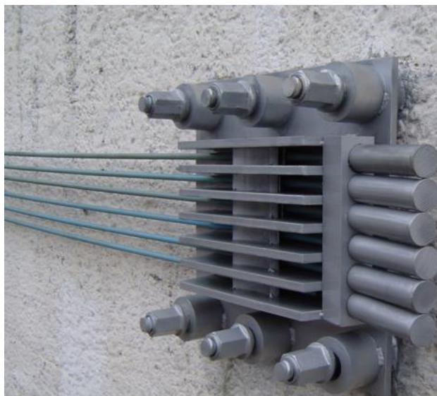
Figura 08 - Detalhe de placa metálica de apoio
