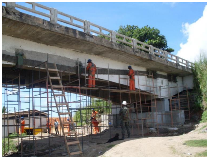
Figura 07 - Protensão externa em viga de obra de arte especial
