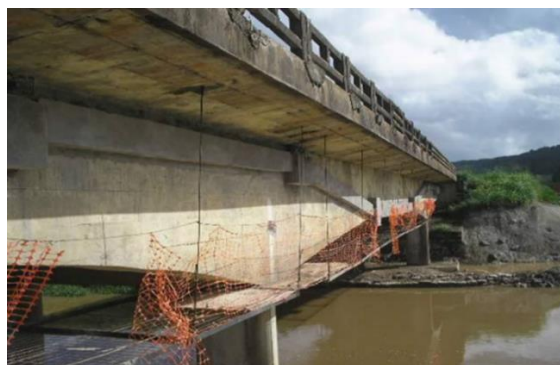
Figura 10 - Cobertura de concreto após protensão
