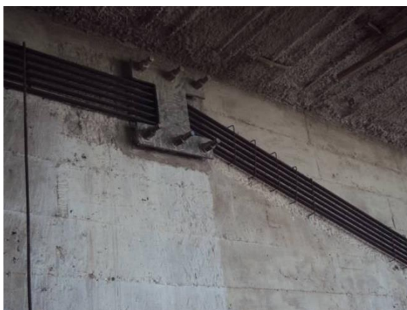
Figura 09 - Detalhe de placa metálica de desvio
