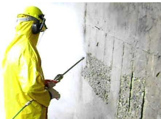
Figura 05 - Remoção de concreto com jato de água sob alta pressão
