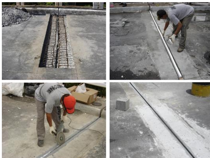
Figura 02 - Detalhe da substituição de junta de dilatação
